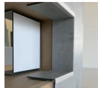
Nische oder Fensterlaibung seitlich gekantet, oben und unten mit Aus- seneckprofilen
