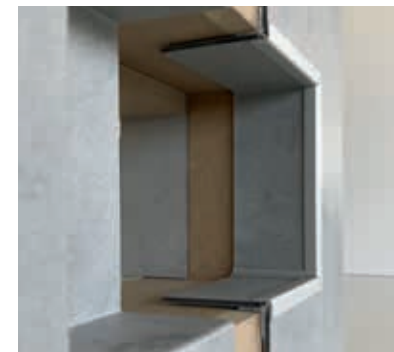
Nische oder Fensterlaibung mit Aussen- und Inneneckprofilen
