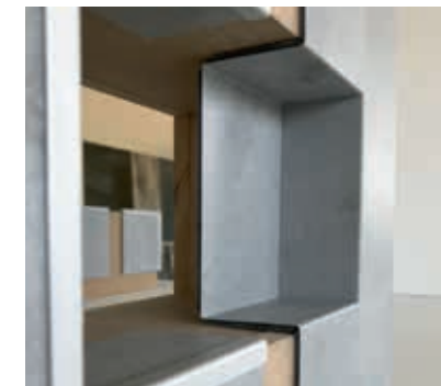
Nische 1 Platte seitlich gekantet, 1 Platte 4-fach gekantet
